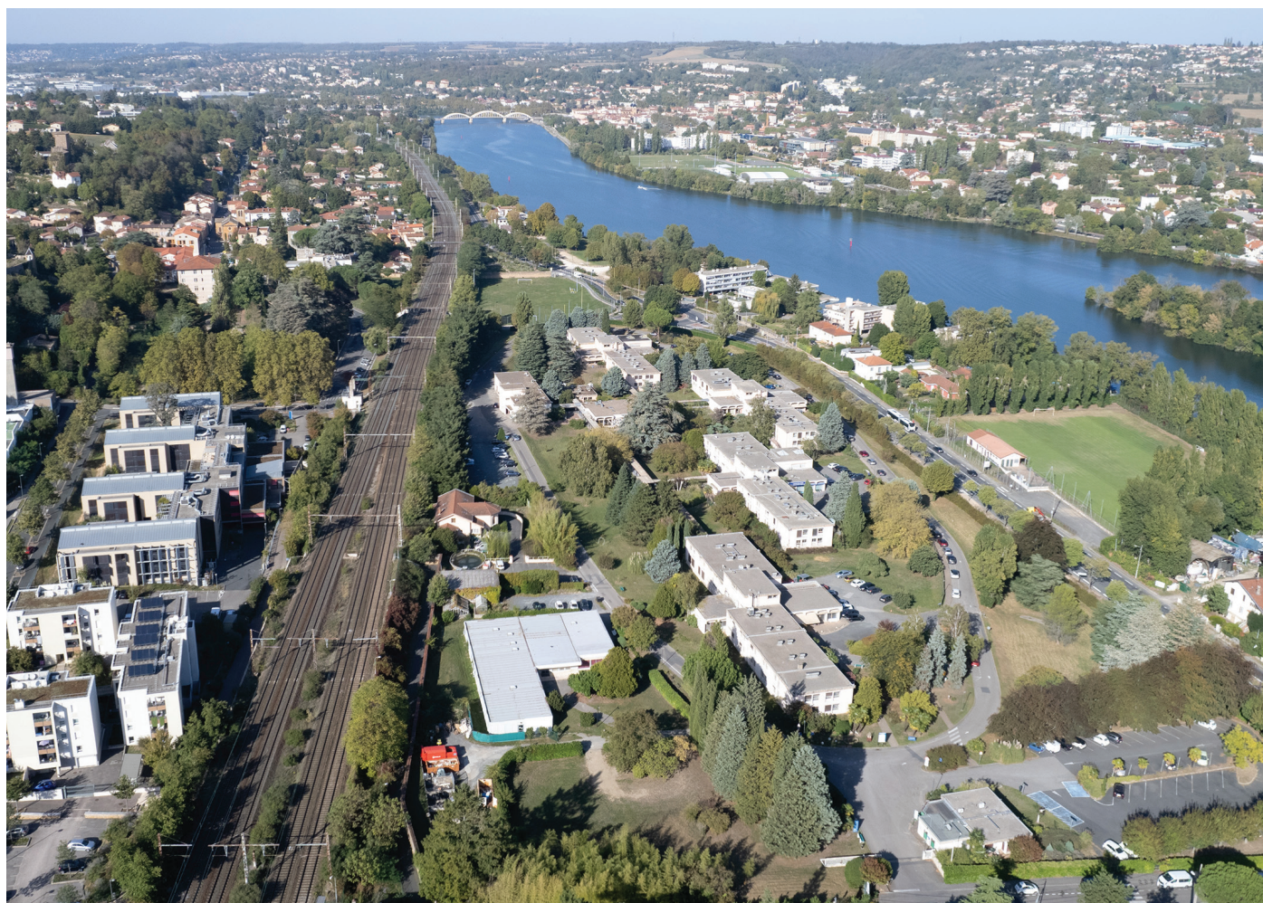
Site de La Mignonne sur Albigny s/ Saône (secteur sanitaire + EHPAD JC)
